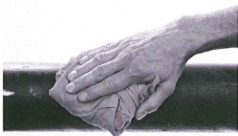
Rohroberfläche reinigen. Keinen Schmutz, lose Anstriche oder Beschichtungen unter der Dichtung. Rohraußendurchmesser mit Spannbereich vergleichen.
