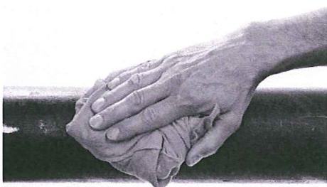
Rohroberfläche reinigen. Keinen Schmutz, lose Anstriche oder Beschichtungen unter der Dichtung.
