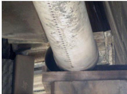
Zustandsaufnahme: Ausgerutschte Rohre aus der Rohrkupplung mangels korrekter Verlegung
