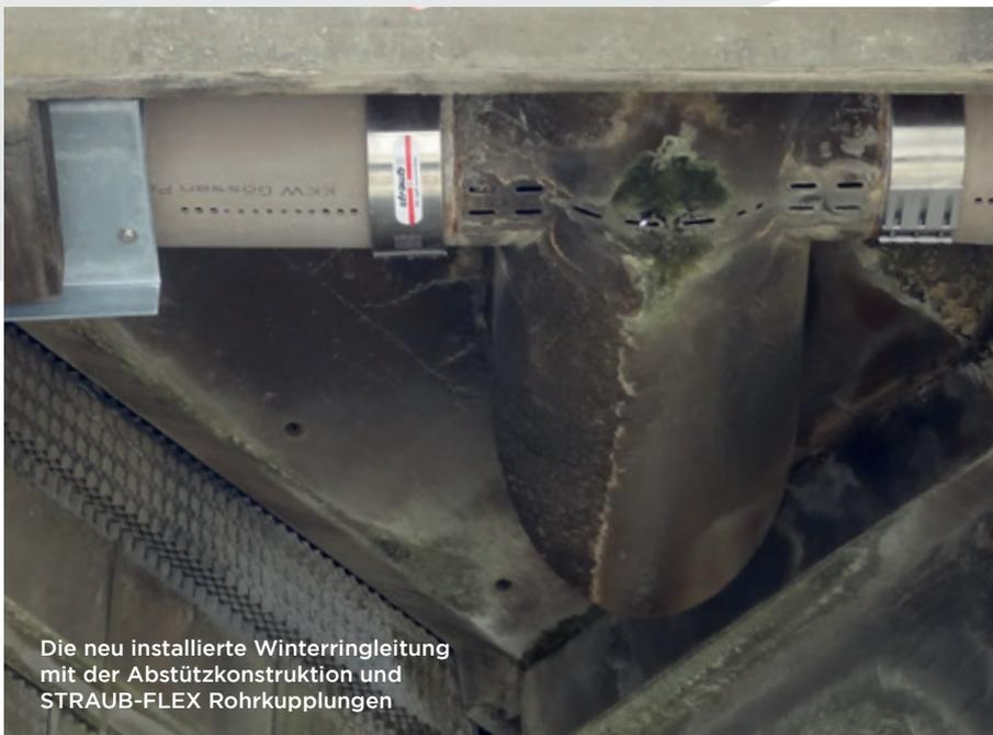
Die neu installierte Winterringleitung mit der Abstützkonstruktion und STRAUB-FLEX Rohrkupplungen
