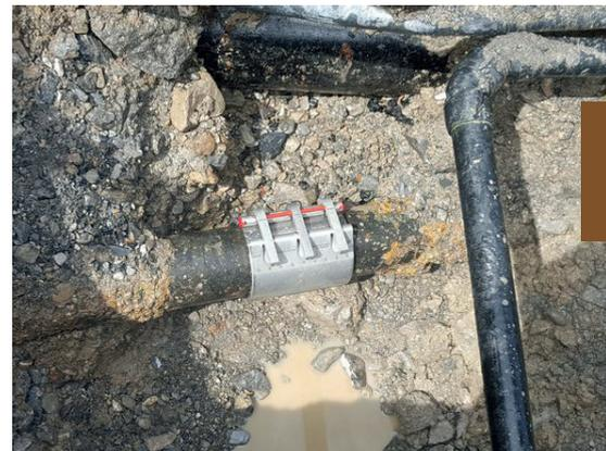
Fuite sur un tube ; réparation rapide et durable avec un raccord STRAUB-REP-FLEX.
