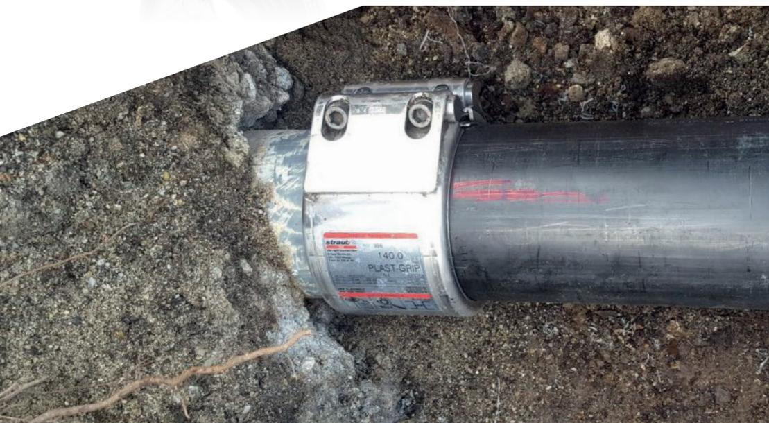
Pour raccorder des tubes PE/PP, utiliser des bagues de renforcement STAUB.
