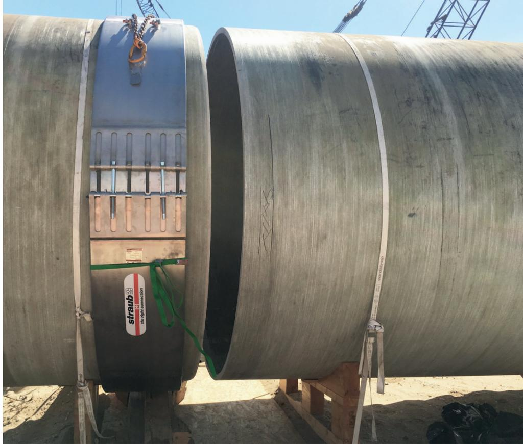
Les feuillards à employer en cas de : grands écarts entre les extrémités, gonflement du joint au contact du liquide, des conduites sous vide, surpression externe, haute température. Les feuillards sont des extras et doivent être commandés à part.
