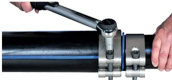
Serrer les vis avec la clé dynamométrique selon le couple de serrage indiqué. Répétez en alternance le processus de serrage jusqu'à ce que tous les boulons aient atteint le couple de serrage spécifié à un quart de tour (90°) près.
