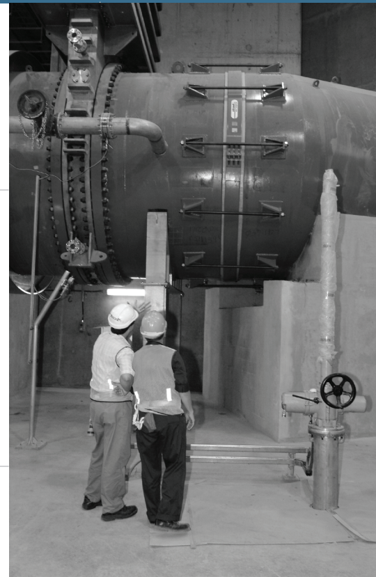
Fachkräfte verbauten 4 Rohrkupplungen mit 3.6 m Durchmesser.
